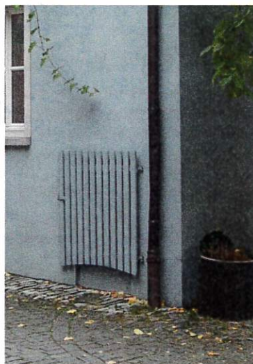
Elektroanschlusskasten eingelassen im Gebäude oder eingebaut
