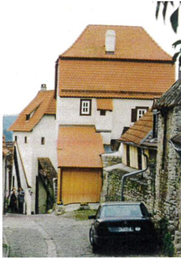
Holzverschalter Anbau an einem Wehrturm
