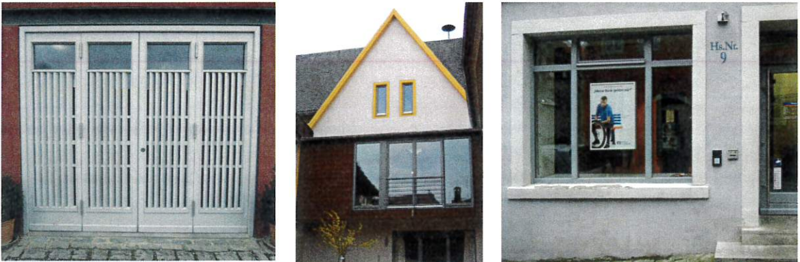
Sonstige Fensterelemente und ein Schaufenster
