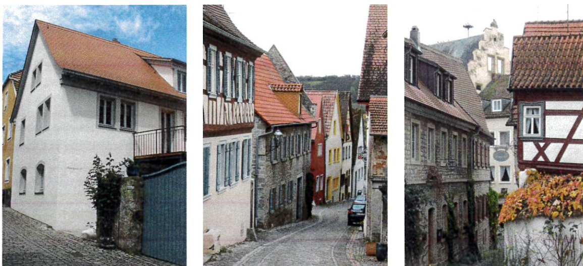
Fachwerk und Mauerwerk verputzt, Sichtfachwerk und Natursteinmauerwerk sind ortsüblich
